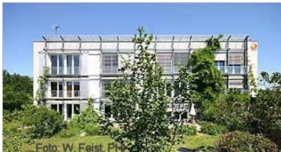
Εικόνα 1.6 Το πρώτο παθητικό κτίριο που κατασκευάστηκε. Φωτογραφία από τον Wolfgang Feist.
