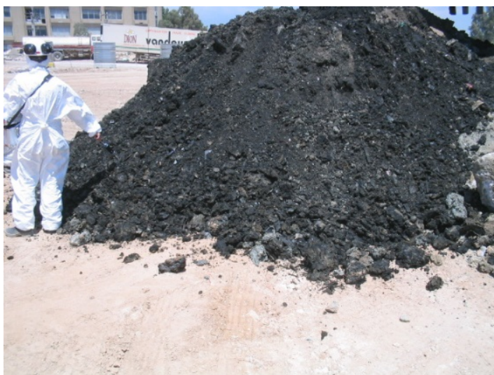
Διαχείριση ρυπασμένων υλικών αποκομιδής με ειδικές προδιαγραφές διάθεσης (Μάνια Μπενίση©, φωτογραφικό αρχείο, Αττικό Μετρό Α.Ε.)
