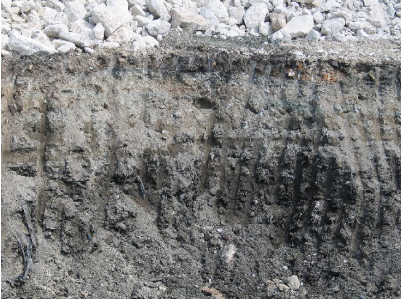
Ασυμφωνία μεταξύ κατώτερου τειφρού ρυπασμένου εδαφικού ορίζοντα και υπερκείμενης νέας επίχωσης βιομηχανικού τσιμέντου, απορριφθέντος και στερεοποιηθέντος in situ μετά το '90-Μάνια Μπενίση ©, φωτογραφικό αρχείο, Αττικό Μετρό Α.Ε.
