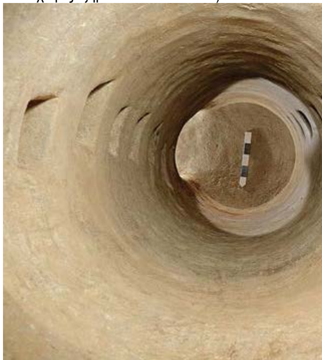
Λαξευτές χειρολαβές στον φυσικό βράχο της μαργας Πειραιά εντός του οποίου κατασκευάζονταν τα αρχαία πηγάδια, δεξαμενές και υδραγωγεία μέχρι το βάθος του υδροφόρου ορίζοντα. Αυτές εξασφάλιζαν επισκεψιμότητα στον πυθμένα του πηγαδιού ώστε να είναι εφικτός ο περιοδικός καθαρισμός του από το ίζημα. Πηγή φωτογραφίας: Εφορεία αρχαιοτήτων Πειραιώς & Νήσων©.
