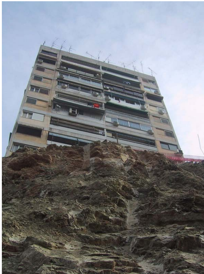
Εκσκαφή ορύγματος C/C σταθμού Αγ. Αντωνίου στο όριο της οικοδομικής γραμμής του συγκροτήματος εργατικών πολυκατοικιών στο Περιστερί το 2004, φωτογραφία Μ. Μπενίση ©, φωτογραφικό αρχείο Αττικό Μετρό Α.Ε.
