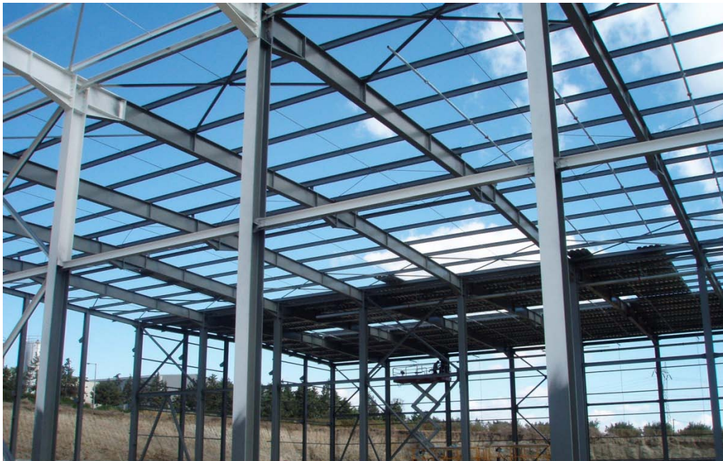
Εικόνα 1.1: Μεταλλικός βιομηχανικός χώρος υπό κατασκευή
