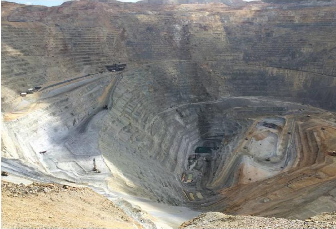
Εικόνα 46: Το μεταλλείο μετά τις εργασίες αποκατάστασης (Ward 2015)
