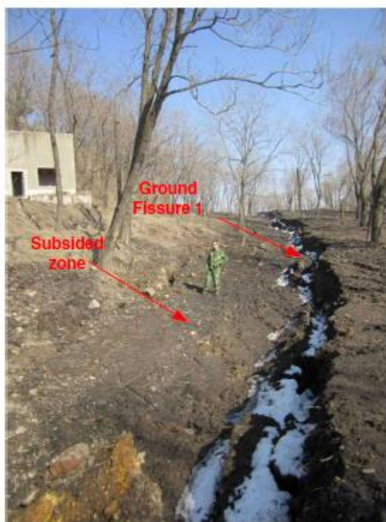
Εικόνα 67: Φωτογραφία της εδαφικής ρωγμής 1 στην κεφαλή της κατολίσθησης (Nie L. κ.α. 2014)
