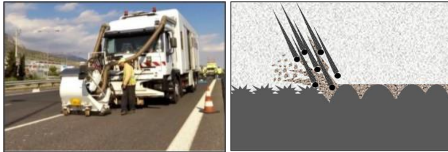
Εικόνα 6.14: Λειτουργία μεθόδου σφαιριδιοβολής ή shotblasting
