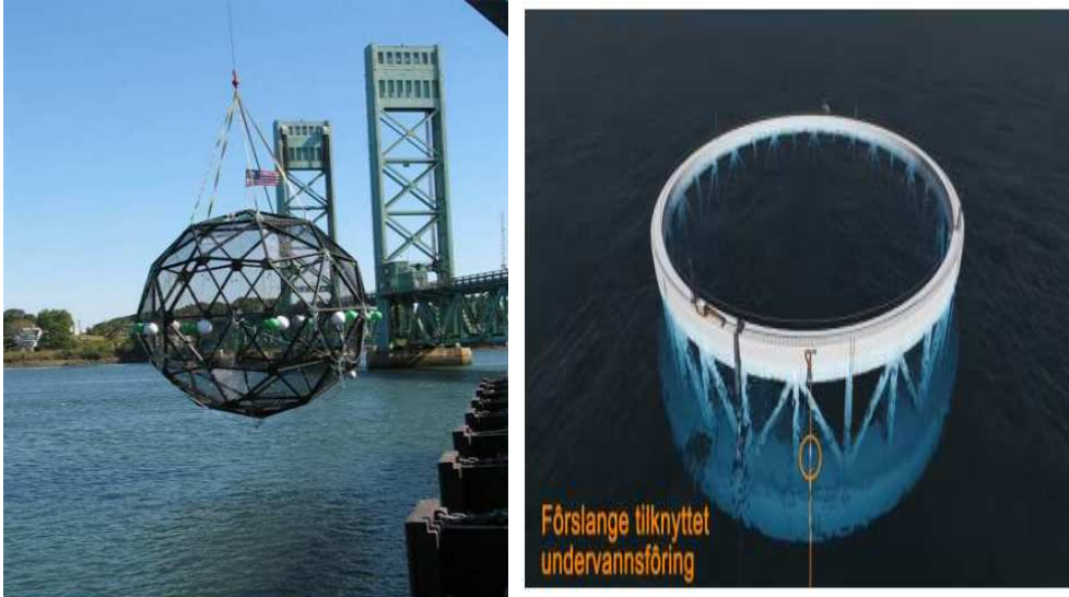
Εικόνα 7.11: Σφαιρικός βυθιζόμενος κλωβός και Κυλινδρικός βυθιζόμενος κλωβός Πηγή: Στεργίου, 2011 και Δημητρίου, 2017 αντίστοιχα.
