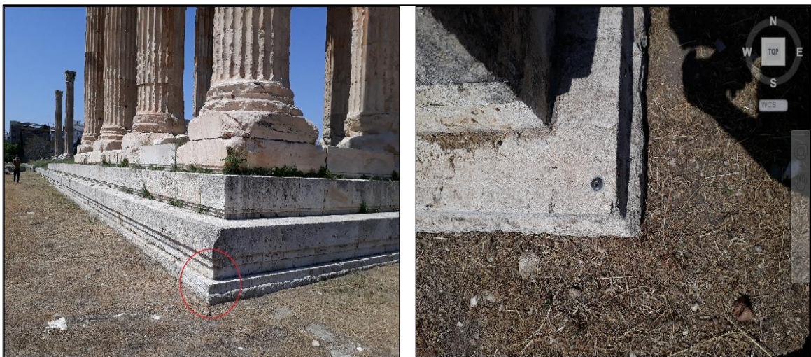
Εικόνα 3.7: Η θέση της υψομετρικής αφετηρίας R1. Picture 3.7: The position of the vertical reference point R1.
