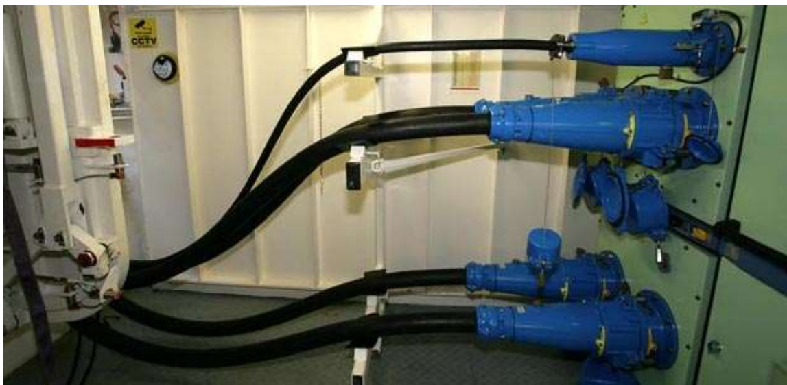
Σχήμα 8.3 Σύνδεση καλωδίων με το πλοίο
