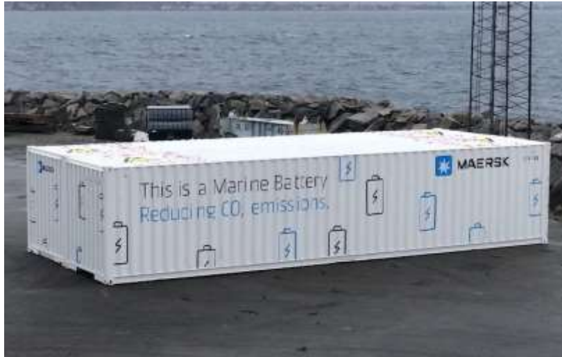
Σχήμα 7.1 Σύστημα Μπαταριών σε containers
