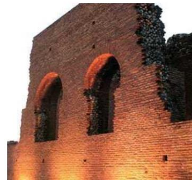
Εικόνα 8 Χυτή τοιχοποιία από το Ρωμαϊκό Ωδείο Πατρών
