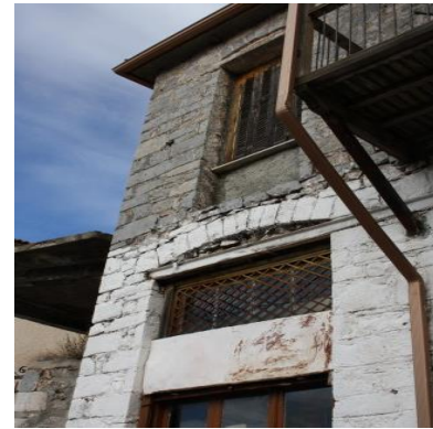
Εικόνα 7 Λιθοδομή με ημιλαξευτούς λίθους
