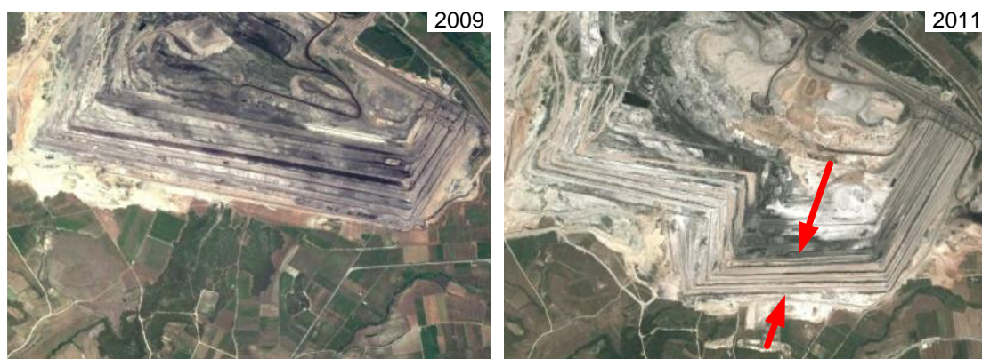
Εικόνα 8 Προχώρηση εκσκαφής δυσμενούς κλίσης στη Μαυροπηγή λόγω καθυστέρησης στη διαδικασία απαλλοτριώσεων (Zevgolis et al. 2019)
