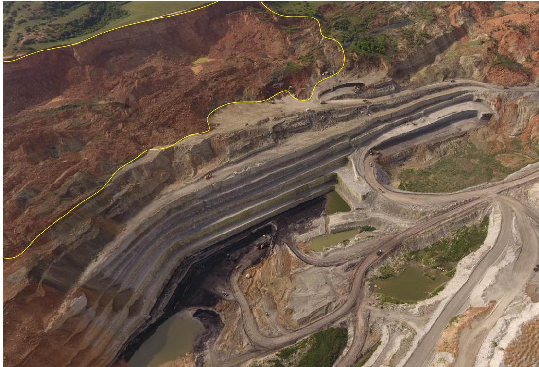
Εικόνα 12 Εναέρια άποψη του λιγνιτωρυχείου Λάβας και των σχετικών κατολισθήσεων το 2018 (φωτογραφία από GMMSA LARCO) (Zevgolis et al. 2019)
