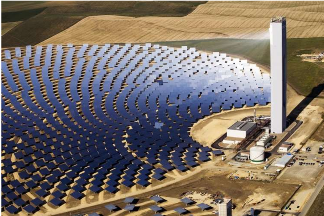
Σχήμα 2. 14: Ηλιακός πύργος ισχύος με το αντίστοιχο πεδίο ηλιοστατών [2.18].
