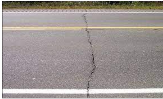
Εικόνα 2.27 Παράδειγμα εγκάρσιας ρηγμάτωσης σε δύσκαμπτο οδόστρωμα
