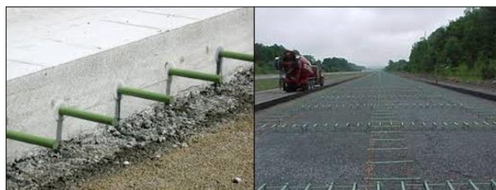
Εικόνα 2.18 Βλήτρα σε δύσκαμπτα οδοστρώματα
