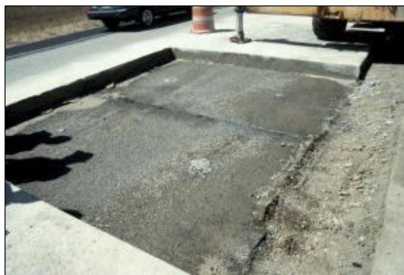
Εικόνα 3.11 Επισκευή πλήρους βάθους-Παράγοντας P του δείκτη PSI
