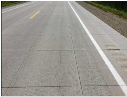
Εικόνα 2.11 Οδόστρωμα από άοπλο σκυρόδεμα με αρμούς (JPCP)
