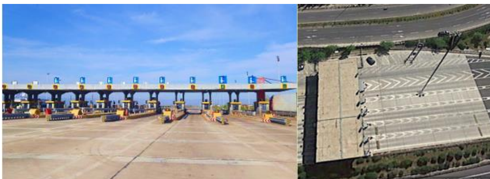
Εικόνα 2.2 Δύσκαμπα οδοστρώματα σε δάπεδα διοδίων
