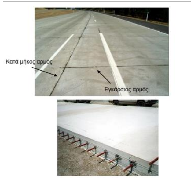
Εικόνα 2.17 Παραδείγματα αρμών δύσκαμπτων οδοστρωμάτων
