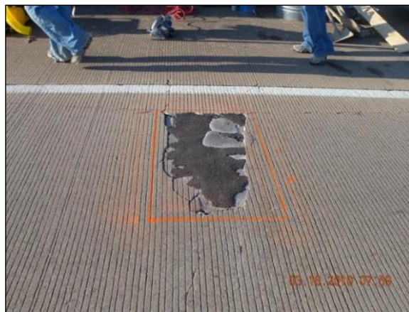
Εικόνα 3.10 Τοπικές επισκευές (μπαλώματα)-Παράγοντας P του δείκτη PSI
