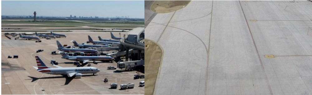
Εικόνα 2.3 Δύσκαμπα οδοστρώματα σε δάπεδα στάθμευσης αεροδρομίων
