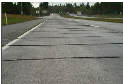
Εικόνα 2.25 Παράδειγμα ανισοσταθμίας πλακών σε δύσκαμπτο οδόστρωμα
