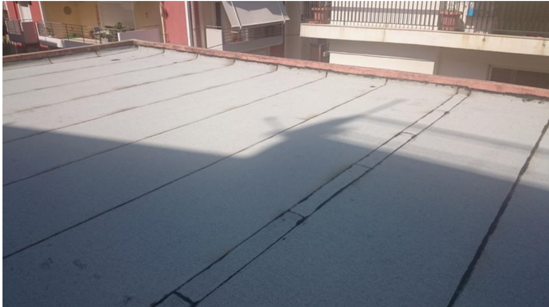
Εικόνα 55. Υγρομόνωση δώματος με ασφαλτόπανο [48]
