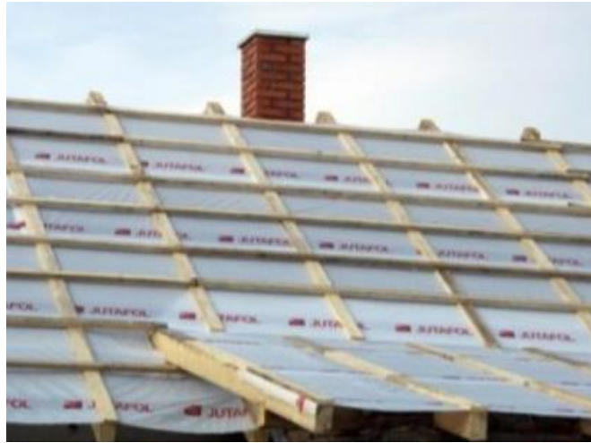
Εικόνα 54. Τοποθέτηση φράγματος υδρατμών σε στέγη [47]
