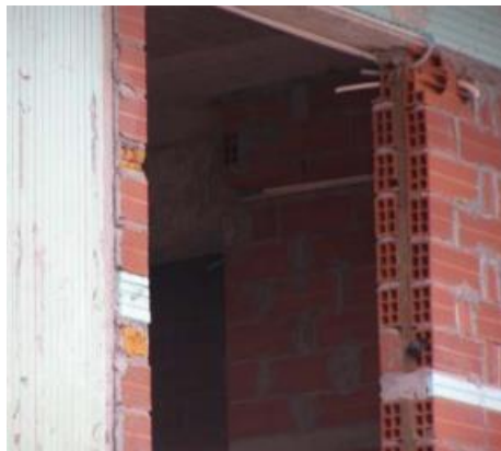
Εικόνα 48. Τοιχοποιία με θερμομόνωση στον πυρήνα [34]
