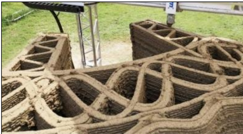
Εικόνα 2.3 Τμήμα σπιτιού το οποίο εκτυπώνεται με υλικό με βάση τη λάσπη, μέσω του προγράμματος TECLA.
