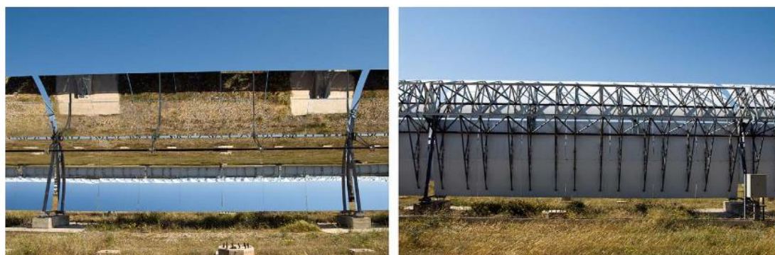
Εικόνα 1.20 Μπροστινή (αριστερή) και πίσω (δεξιά) όψη του συλλέκτη EuroTrough [1.31]
