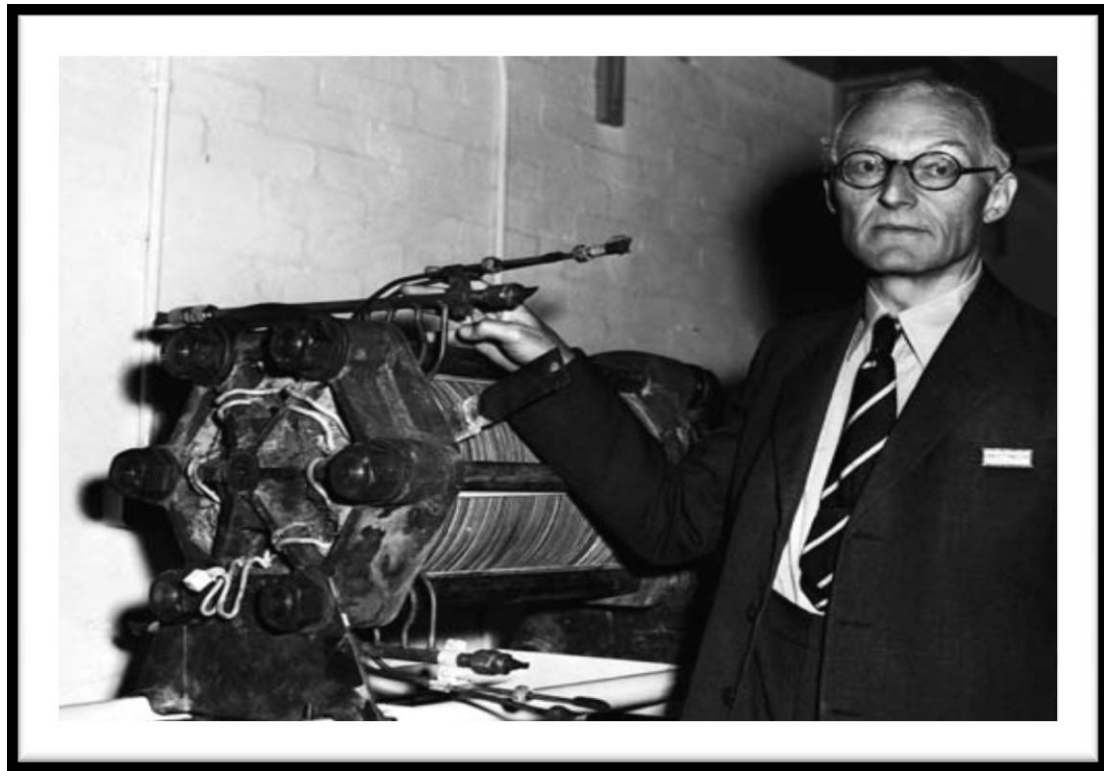
Σχήμα 2.2: Ο Bacon με την κυψέλη καυσίμου των 6kW. (Copyright Hulton-Deutsch Collection/Corbis).
