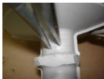
Εικόνα 2.4. Τράβηγμα τετραγώνων με την βοήθεια πένσας [25]
