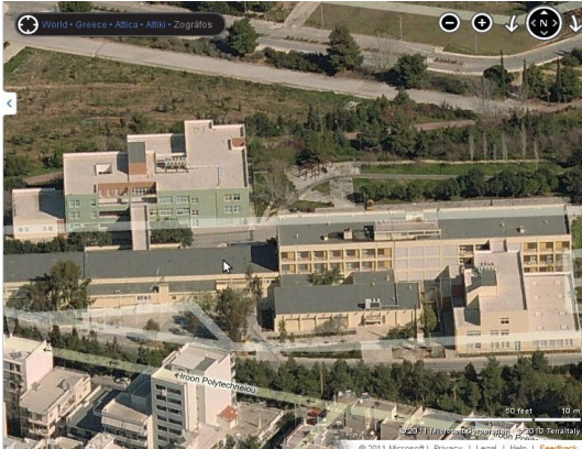
Εικόνα 5.12: Κτήρια Τοπογράφων με βόρειο προσανατολισμό
