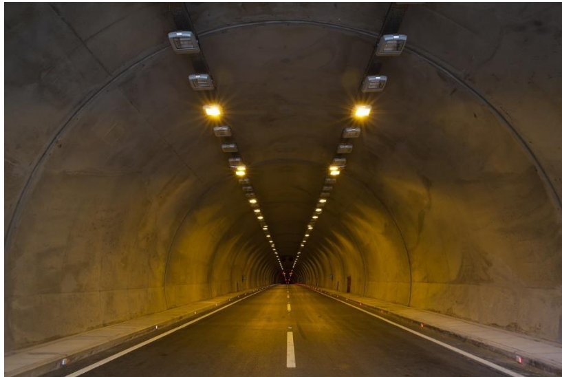
Εικόνα 1: Εσωτερικό οδικής σήραγγας
