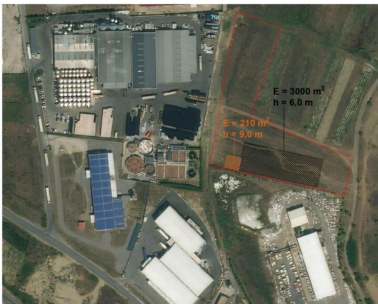
Εικόνα 3.3: Χωροθέτηση των κτηριακών εγκαταστάσεων στα πλαίσια του νέου επενδυτικού σχεδίου, στις οποίες θα φιλοξενηθεί ο λέβητας βιομάζας και θα αποθηκεύεται η θρυμματισμένη υπολειμματική βιομάζα, που θα τον τροφοδοτεί με καύσιμο. (Πηγή: πρωτότυπο)
