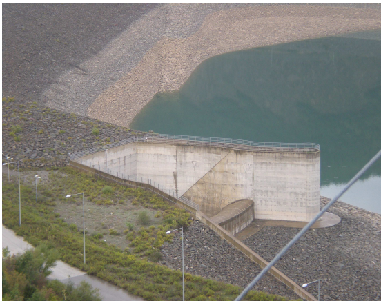
Σχήμα 4.15 : Όψη εισόδου υπερχειλιστή - Entry spillway
