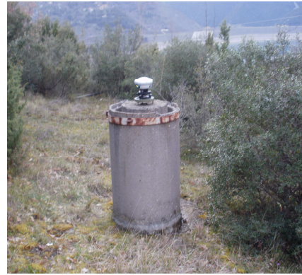
Σχήμα 5.21: Το σημείο αναφοράς με κωδικό T4 του τριγωνομετρικού δικτύου του φράγματος - The reference point with code T4 of the trigonometric network of the dam
