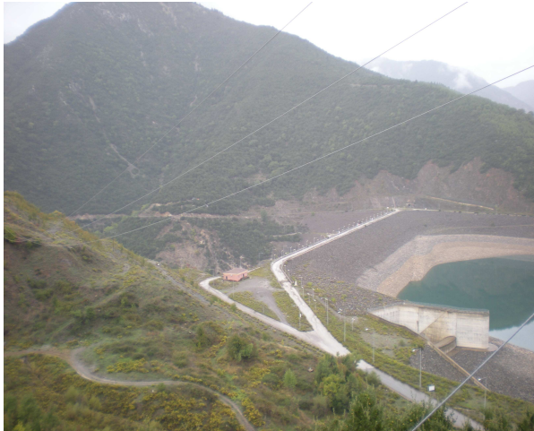
Σχήμα 4.12 : Στέψη και ανάντη πρανές φράγματος Ευήνου – Crest and Upstream slope dam Evinos
