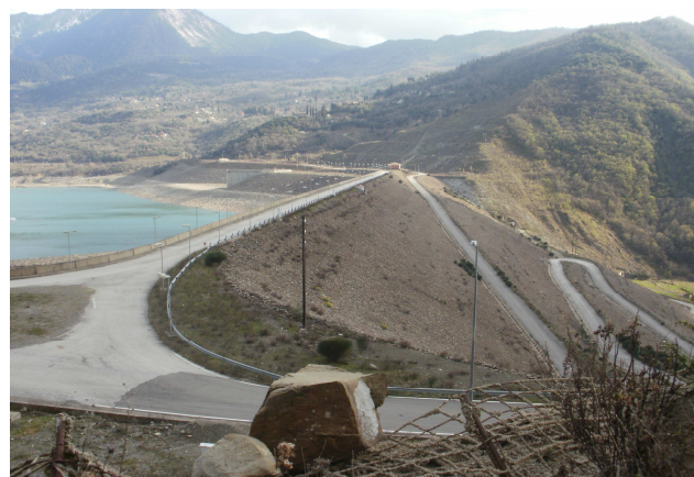
Σχήμα 4.18 : Πανοραμική όψη φράγματος - Panoramic view of the dam
