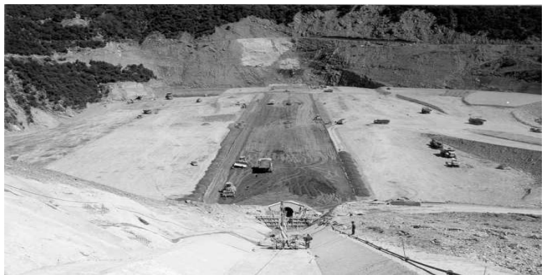
Σχήμα 4.11 : Κατασκευή της στοάς τσιμεντενέσεων και του αναχώματος – Construction of the gallery grouting and embankment, Πηγή : «Το φράγμα του Ευήνου – Σχεδιασμός, Κατασκευή, Πλήρωση και Λειτουργία» (Γ. Ντουνιάς, Ι. Καραβοκύρης, Δ. Νικολάου)
