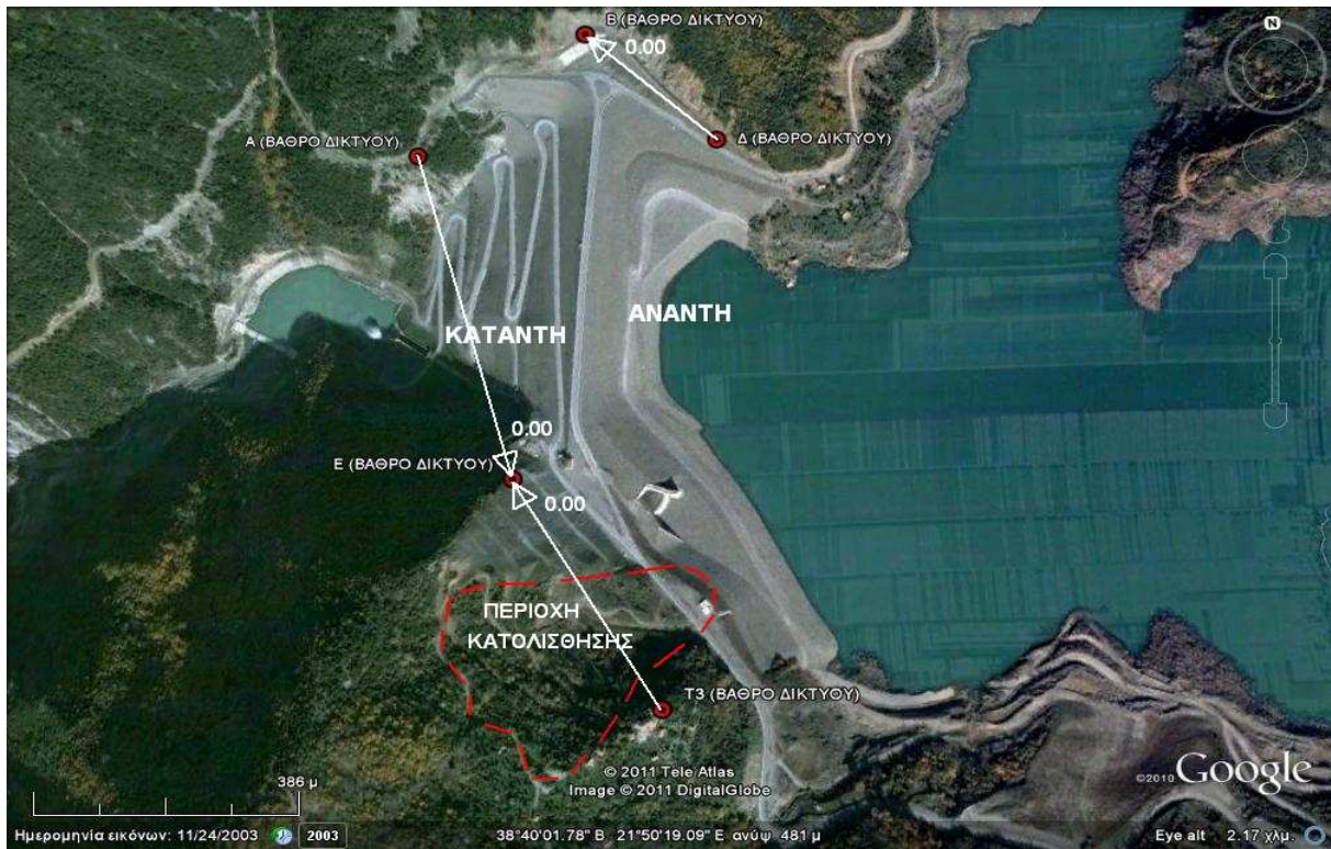
Σχήμα 7.1: Τα σημεία αναφοράς του δικτύου (A,B,Δ,E,T3) απ’ όπου γίνονται οι επίγειες παρατηρήσεις (διεύθυνση μηδενισμού) προς τα σημεία ελέγχου της στέψης (ανάντη και κατάντη) του φράγματος και για τον έλεγχο της κατολίσθησης του αριστερού πρανούς από το τοπογραφικό συνεργείο της ΕΥΔΑΠ Α.Ε.- The reference points of the network (A,B,D,E,T3), where are the sites for the ground observations to the control points of crest (upstream and downstream) of the dam and to control the landslide from the left abutment, from the topographic crew of EYDAP S.A., Πηγή: Google Earth
