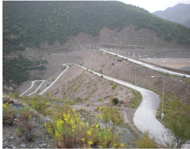
Σχήμα 4.13 : Στέψη και κατόντη πρανές φράγματος Ευήνου – Crest and Downstream slope dam Evinos
