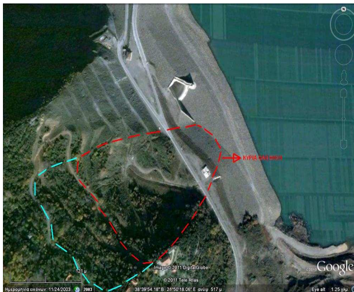
Σχήμα 4.19 : Γενική άποψη κατολίσθησης – General view of landslide , Πηγή : Google Earth
