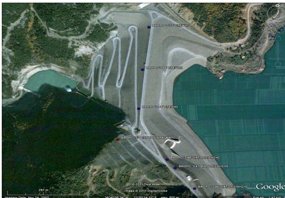
Σχήμα 5.11 : Το σημείο αναφοράς του δικτύου με κωδικό E, τα τρία (3) σημεία ελέγχου της στέγης με κωδικούς (S64, S68, S73) και τα τρία (3) σημεία ελέγχου για τον έλεγχο της κατολίθησης με κωδικούς (S44, S47, S48) όπου μετρήθηκαν με GPS στις 27/3/2011 – The reference point of the network code E, the three (3) control points of crest with codes (S64, S68, S73) and three (3) control points to control the landslide with codes (S44, S47, S48) when measured by GPS at 27/03/2011, Πηγή : Google Earth
