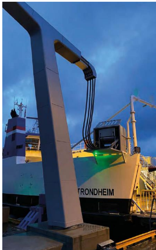
Εικόνα 20 : Shore Connection
