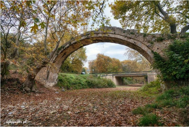
Εικόνες 5.5-5.6 - Αριστερά: Γέφυρα Αλαμάνου (1858) – Καταβιβασμένη χάραξη, Δεξιά: Γέφυρα Κόνιτσας (1871) - Ημικυκλική χάραξη
