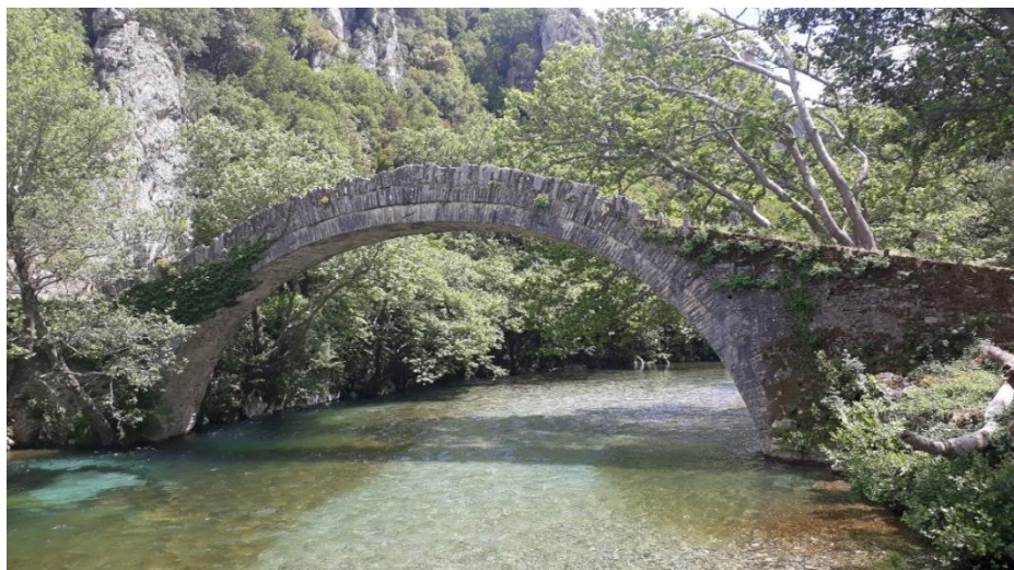
Εικόνα 1.8 - Η γέφυρα της Κλειδωνιάς (φωτογραφία 14/5/2021)
