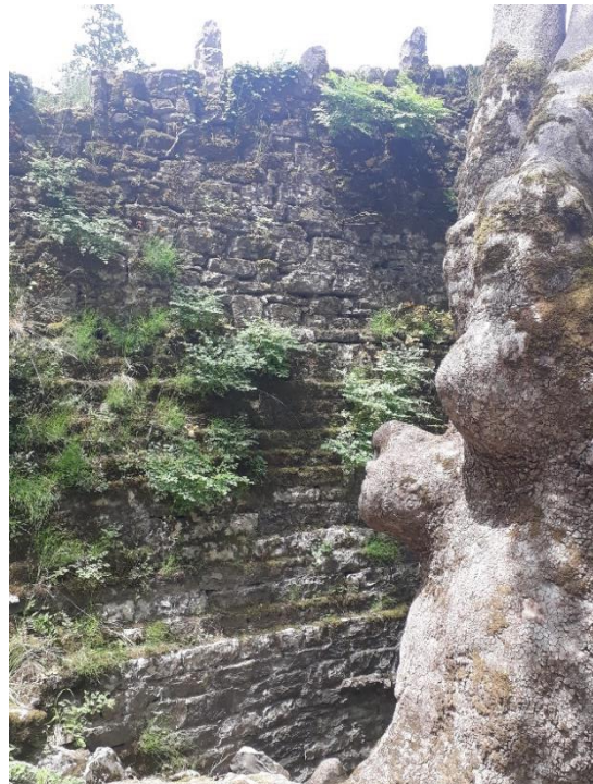
Εικόνες 3.16-3.17 - Αριστερά: Βλάστηση στο κατόντη τύμπανο του Νότιου βάθρου, Δεξιά: Ρηγματώση τυμπάνου Νότιας πρόσβασης
