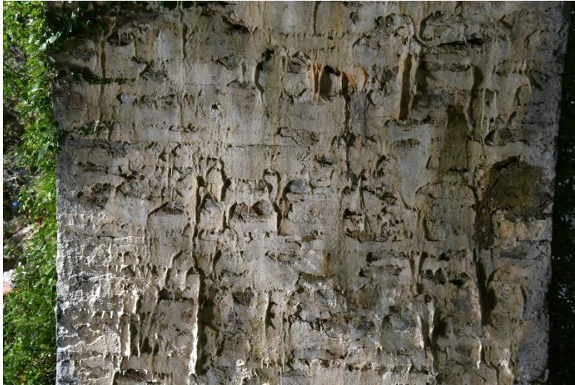
Εικόνα 3.18 - Κρυστάλλωση αλάτων στο εσωράχιο του τόξου (Γιαννέλος Χ.,2019)
