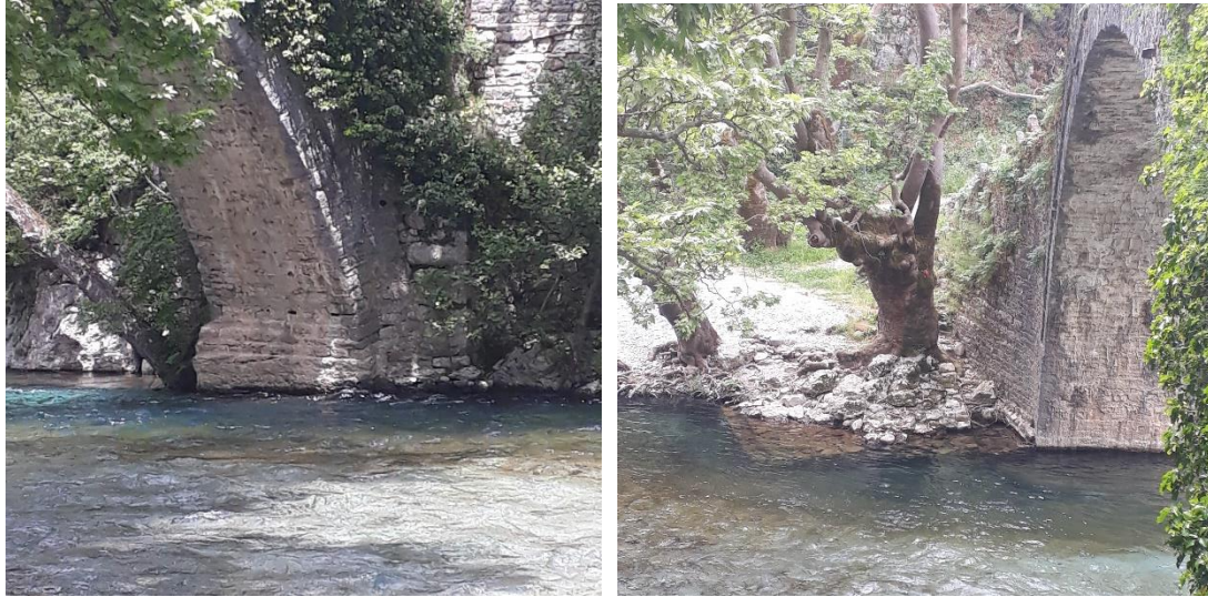
Εικόνες 3.8-3.9 - Αριστερά: Βόρειο ακρόβαθρο προγενέστερης γέφυρας, Δεξιά: Υπολείμματα Νότιου βάθρου προγενέστερης γέφυρας
