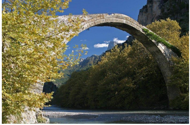
Εικόνες 5.5-5.6 - Αριστερά: Γέφυρα Αλαμάνου (1858) – Καταβιβασμένη χάραξη, Δεξιά: Γέφυρα Κόνιτσας (1871) - Ημικυκλική χάραξη
