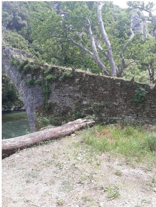
Εικόνες 3.16-3.17 - Αριστερά: Βλάστηση στο κατόντη τύμπανο του Νότιου βάθρου, Δεξιά: Ρηγματώση τυμπάνου Νότιας πρόσβασης
