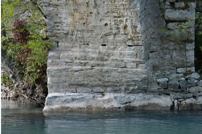
Εικόνα 2.7 - Έδραση βόρειου βάθρου σε βράχο (Γιαννέλος Χ., 2019)
