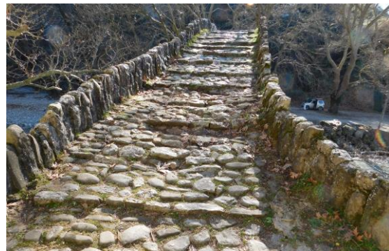
Εικόνες 3.2-3.3 - Το λιθόστρωτο κατάστρωμα από την Νότια και Βόρεια πρόσβαση (φωτογρ. αρχείο Κασκάνη Βασιλείου, 2016)
