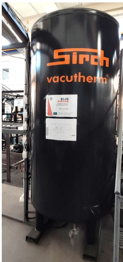
Εικ. 2.5 Απεικόνιση της δεξαμενής αποθήκευσης θερμότητας κενού
