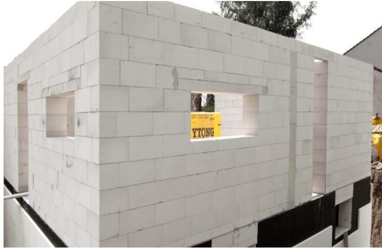
Εικόνα 1.3 : Λιθοδομή από πορομπετόν
