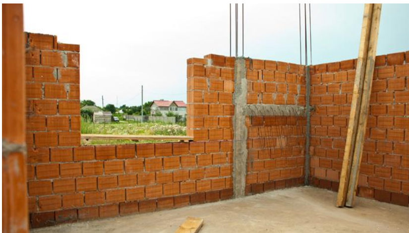
Εικόνα 1.4 : Κατασκευή από οπτοπλινθοδομή
