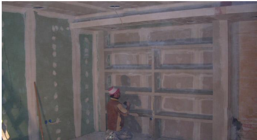
Εικόνα 1.5 : Κατασκευή από τσιμεντοπλινθοδομές
