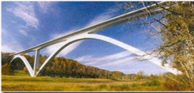
Εικόνα 2.14 Τοξωτή γέφυρα - Χαρακτηριστικό παράδειγμα χρήσης σκυροδέματος υψηλής αντοχής
