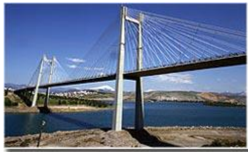
Εικόνα 2.15 Καλωδιωτή γέφυρα - Χαρακτηριστικό παράδειγμα χρήσης σκυροδέματος υψηλής επιτελεστικότητας, λόγω εγγύτητας στην θάλασσα
