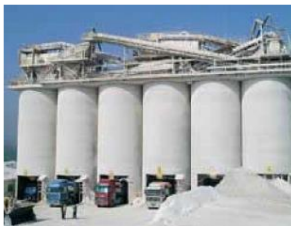
Εικόνα 2.5 Σιλό αποθήκευσης τσιμέντου
