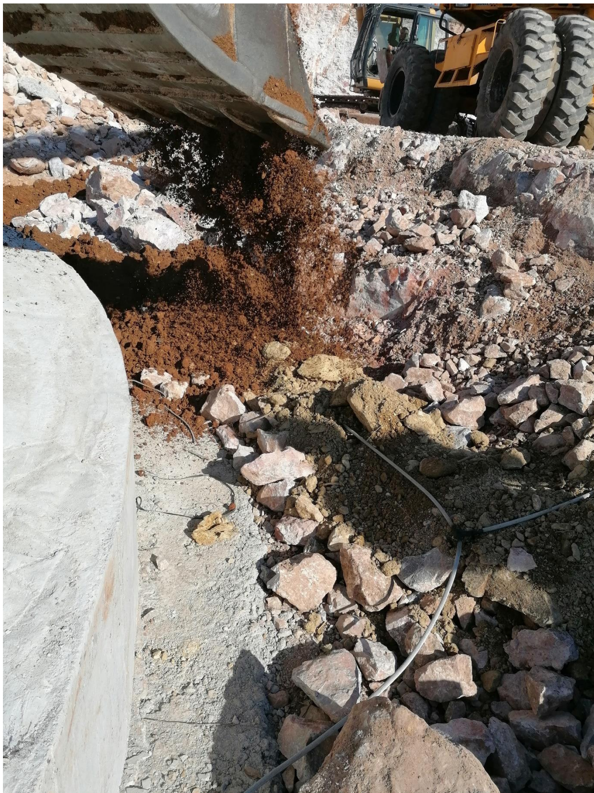
Σχήμα 5.23: Συγκόληση Γείωσης Άνω του Θεμελίου με Περιμετρική Γείωση Πλέγματος
