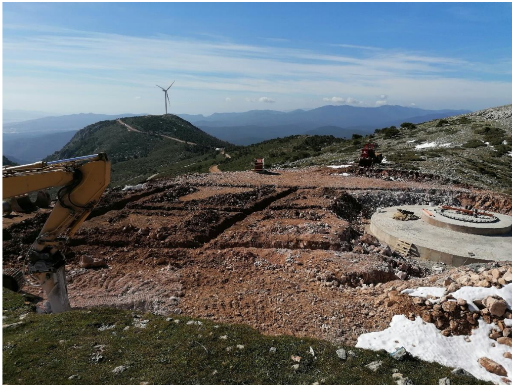
Σχήμα 5.22: Εσκαφή Τάφρου Πλέγματος Γείωσης Περιμετρικά της Θεμελίωσης
