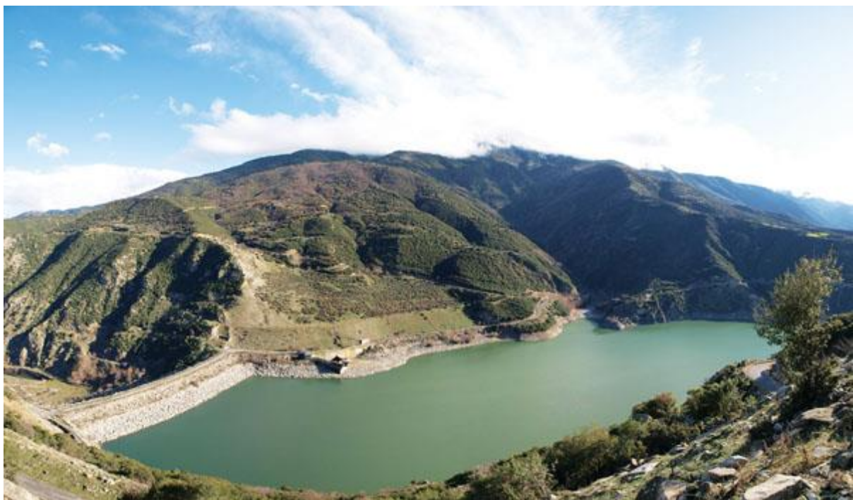
Σχήμα 1.16: Υδροηλεκτρικός Σταθμός Πολύφουτου
