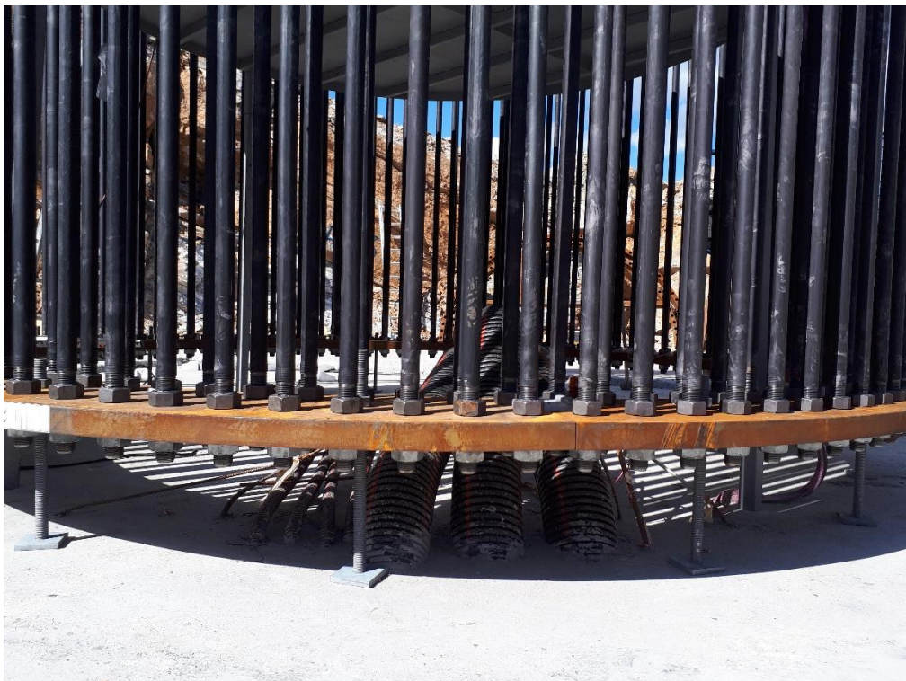
Σχήμα 5.20: Εγκιβωτισμός Σωληνώσεων Καλωδίων
