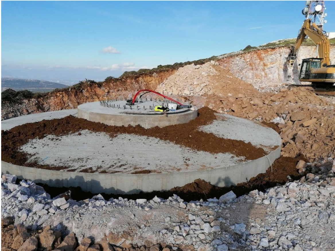
Σχήμα 5.24: Γείωση Άνω του Θεμελίου με Εμπλουτισμό Φυτικού Χώματος για την Προστασία της
