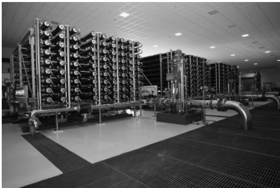
Εικόνα 3: Τυπική μονάδα αντίστροφης όσμωσης 12
