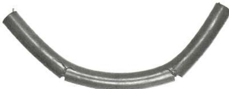
Σχήμα 35. Σπασμένη σωλήνωση εξαιτίας χαμηλής θερμοκρασίας
