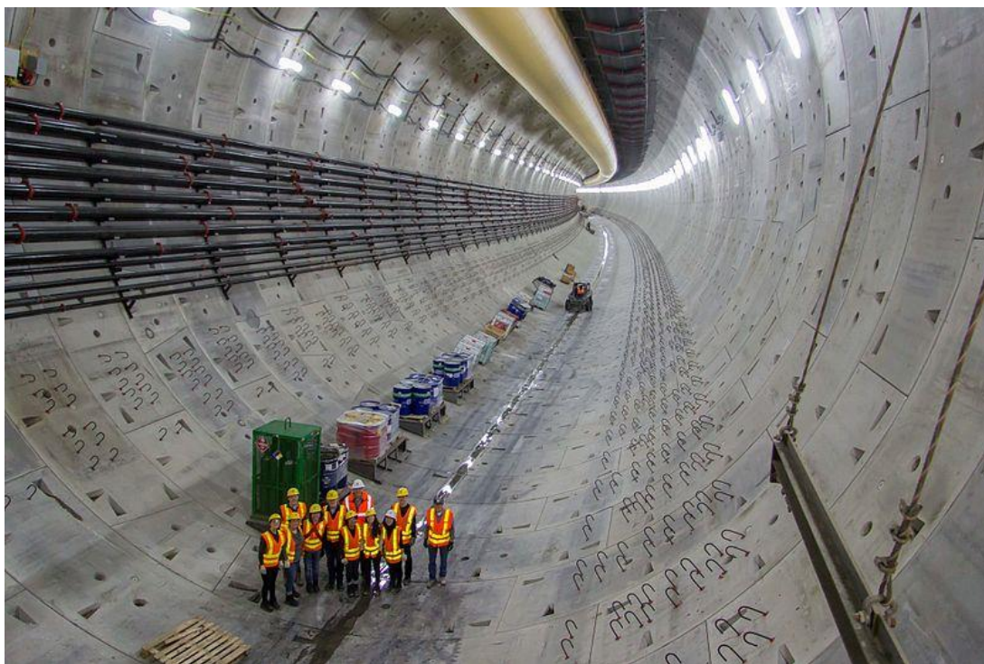
Εικόνα 1.1. Άποψη της κατασκευασμένης σήραγγας διαμέτρου 17.5m του έργου Alaskan Way Viaduct (Seattle).
