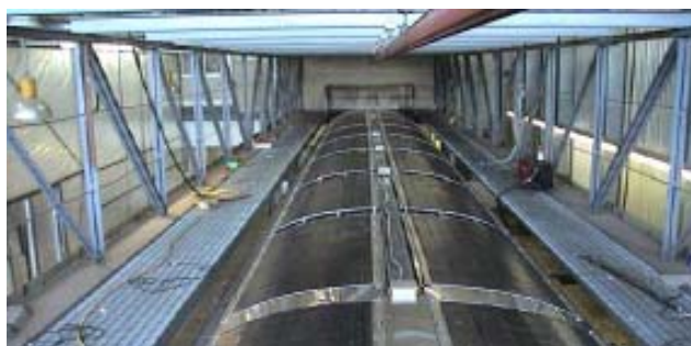
Εικόνα 24: Εγκατάσταση διατάξεων στο πρώτο βαγόνι
