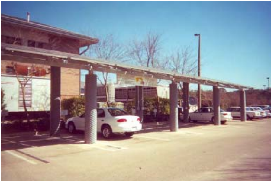
Εικόνα 49: Υπόστεγο στάθμευσης αυτοκινήτων EV με 18 kW από πλέγμα Φ/Β για τη φόρτιση EV που βρίσκεται στο Κυβερνητικό Κέντρο του Ταλαχάσι (1996)
