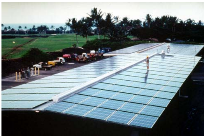
Εικόνα 47: Golf kart εγκατάσταση φωτοβολταϊκών για φόρτιση ηλεκτρικών καρτ στη Χαβάη
