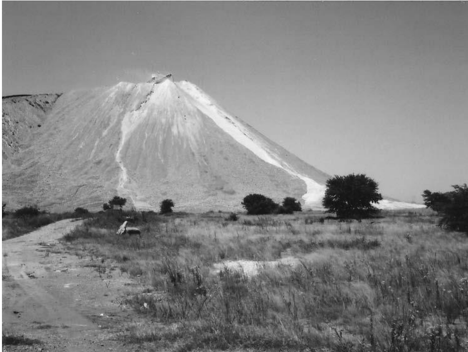
Εικόνα 2-1: Από πάνω προς τα κάτω σωρός απόθεσης στείρων ορυχείου χρυσού (Blight 2010).
