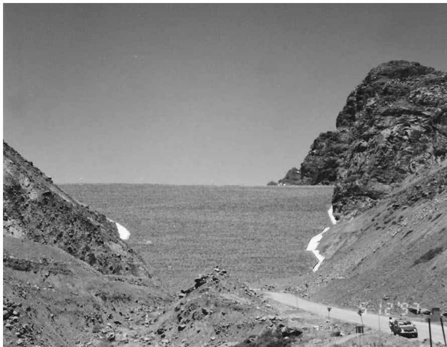
Εικόνα 2-3: Δομή απόθεσης αποβλήτων εγκάρσιας κοιλιάδας (Blight 2010).
