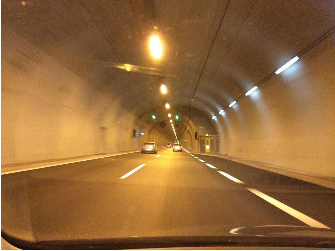
Εικόνα 1 Φωτογραφία από τον δεξιό κλάδο της οδικής σήραγγας Κνημίδας σε θέση parking (πηγή: διαδίκτυο)
