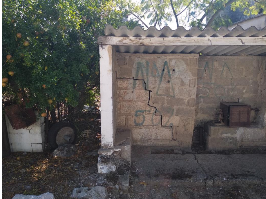
Εικόνα 3-5: Ρωγμή σε κτίριο στα Μαυρόγια.
