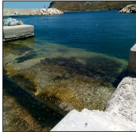
Εικόνα 3-50: α)-β) Στρώμα προστασίας του κρηπιδώματος από λιθορριπή, γ)-δ) Υποχώρηση τμήματος από σκυρόδεμα στη γλύστρα (προσωπικό αρχείο)
