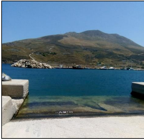
Εικόνα 3-50: α)-β) Στρώμα προστασίας του κρηπιδώματος από λιθορριπή, γ)-δ) Υποχώρηση τμήματος από σκυρόδεμα στη γλύστρα (προσωπικό αρχείο)
