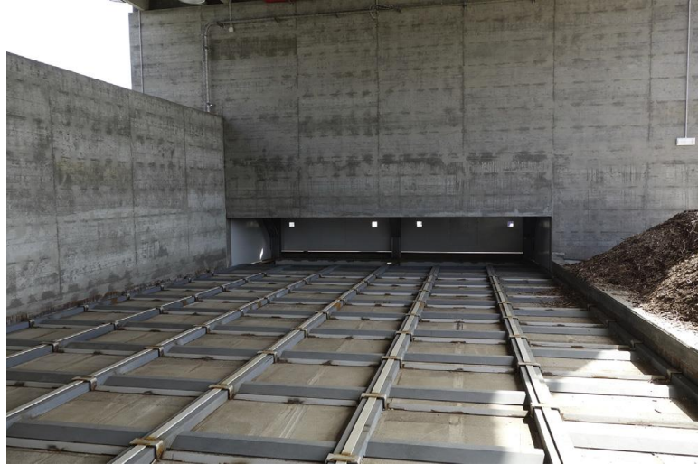
Σχήμα 9 Αποθήκη κινούμενου δαπέδου (ITI Engineering) [10]
