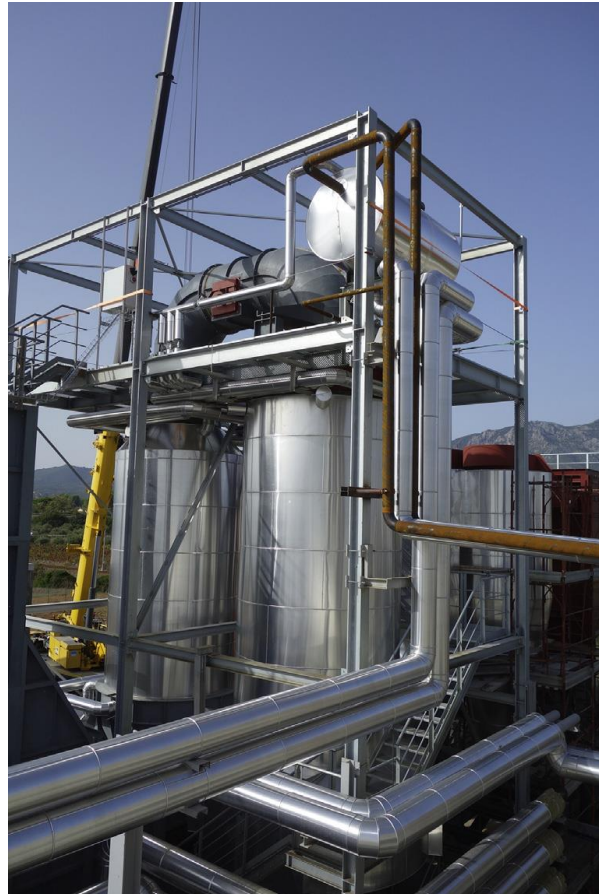
Σχήμα 15 Λέβητας ενδιάμεσου θερμικού ελαίου (ITI Engineering) [10]
