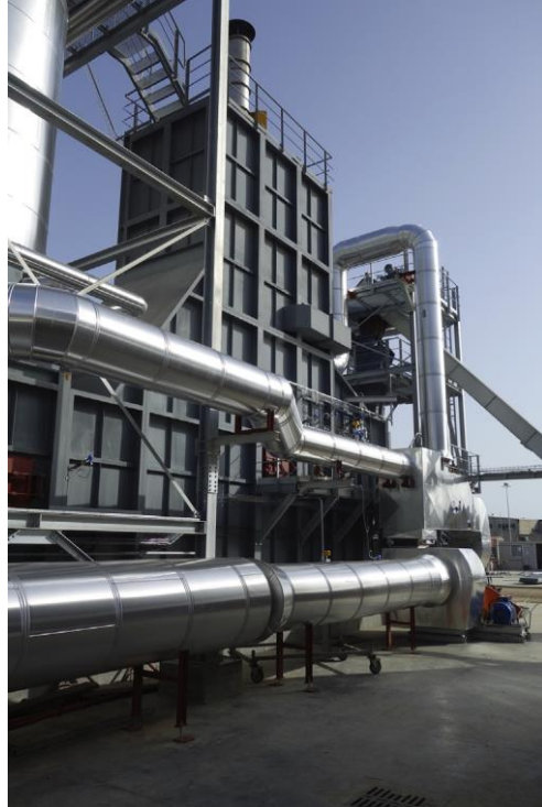
Σχήμα 14 Σύστημα ανατροφοδοσίας καυσίμου και αγωγοί καυσαερίων (ITI Engineering) [10]
