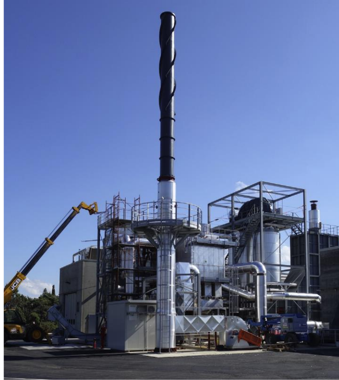
Σχήμα 16 Όψη καπνοδόχου και σακκόφιλτρου (ITI Engineering) [10]
