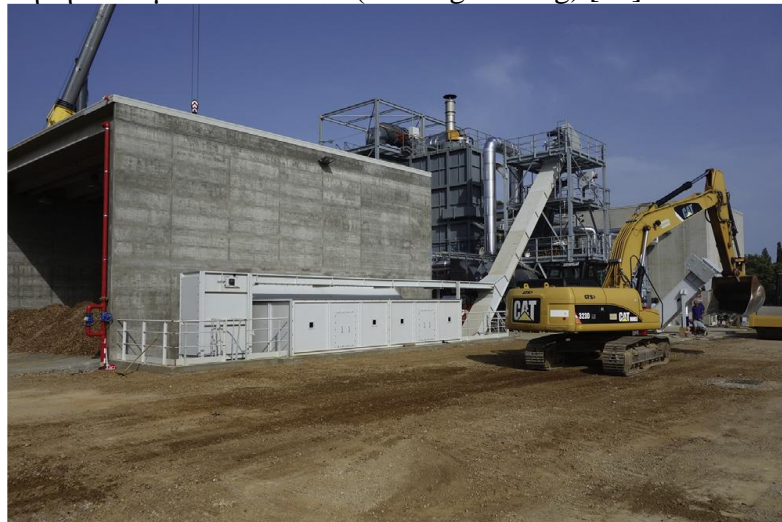
Σχήμα 10 Ιμάντας τροφοδοσίας βιομάζας (ITI Engineering) [10]
