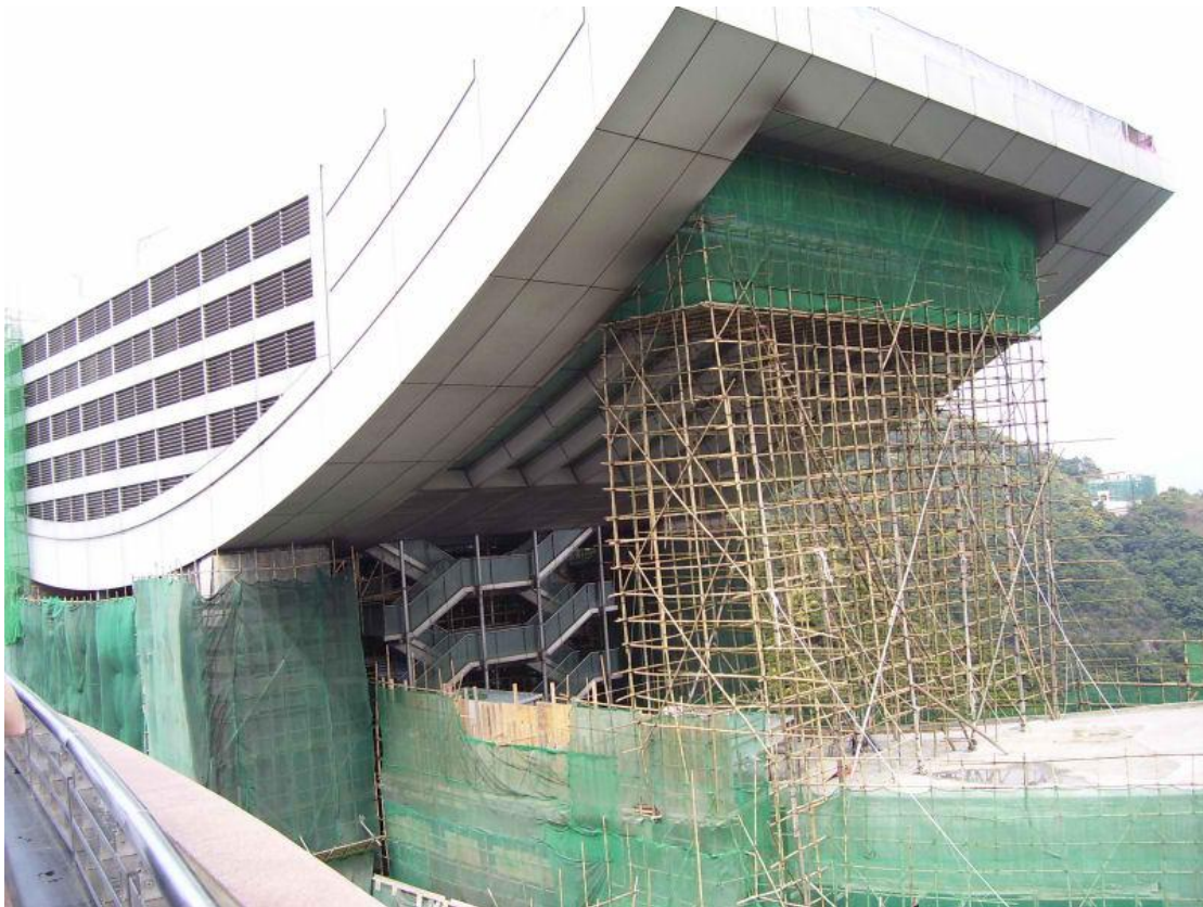
Σχήμα 1.1 : Φωτογραφία ικριωμάτων από μπαμπού σε κτίριο στο Hong Kong
