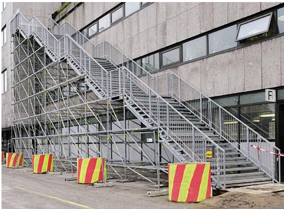
Σχήμα 1.5: Κλιμακοστάσιο για την πρόσβαση σε χώρο εργασίας
