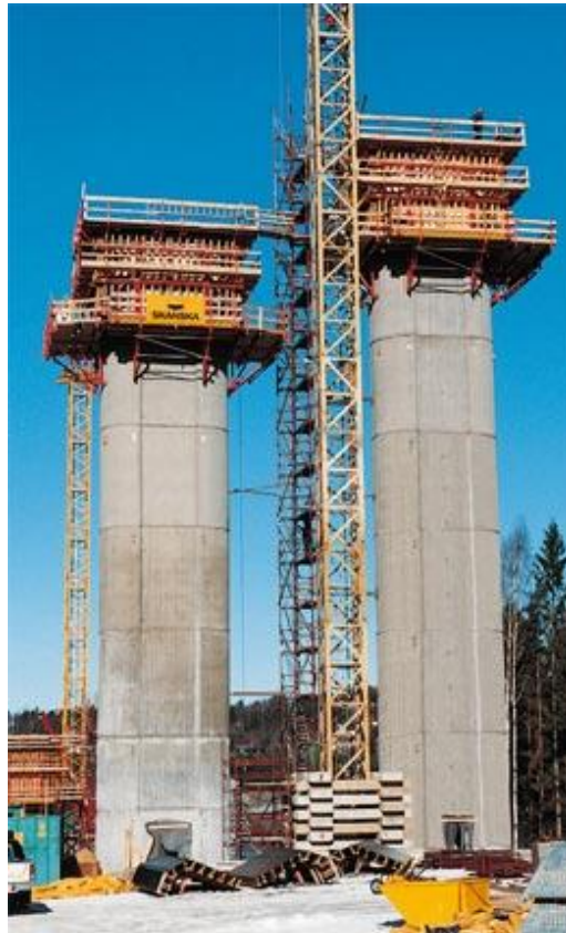
Σχήμα 1.6: Σύστημα αναρρίχησης για την κατασκευή βάθρων γέφυρας
