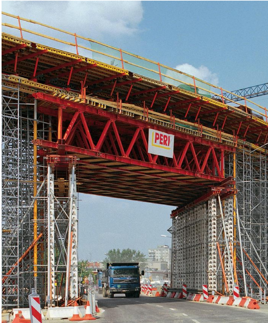
Σχήμα 1.14 : Δικτύωμα για τη γεφύρωση ανοίγματος
