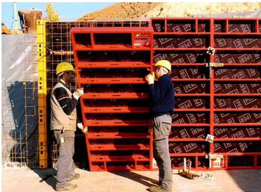
Σχήμα 1.7: Μεταλλότυπος ελαφρύ τύπου με χαλύβδινα πανέλα
