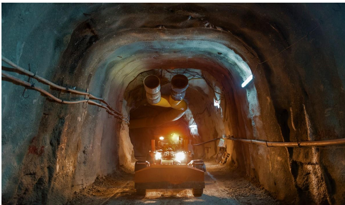
Εικόνα 2.12 : Βοηθητικός αερισμός σε υπόγειο μεταλλείο χρυσού
