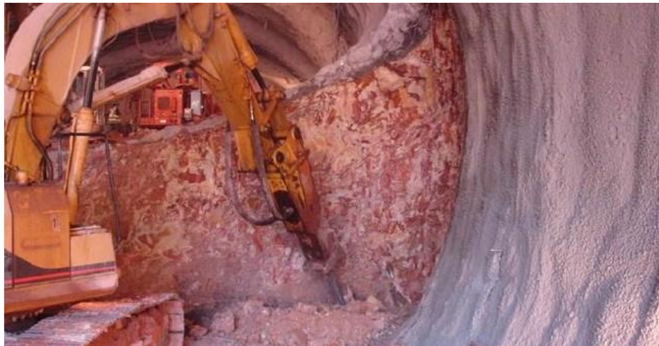
Εικόνα 4.5. Επένδυση του προσωρινού ανάστροφου τόξου με εκτοξευόμενο σκυρόδεμα.
