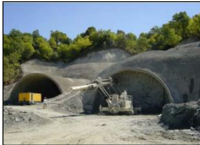
Εικόνα 3.4.Στόμια εισόδου της διπλής σήραγγας Ανθοχωρίου.
