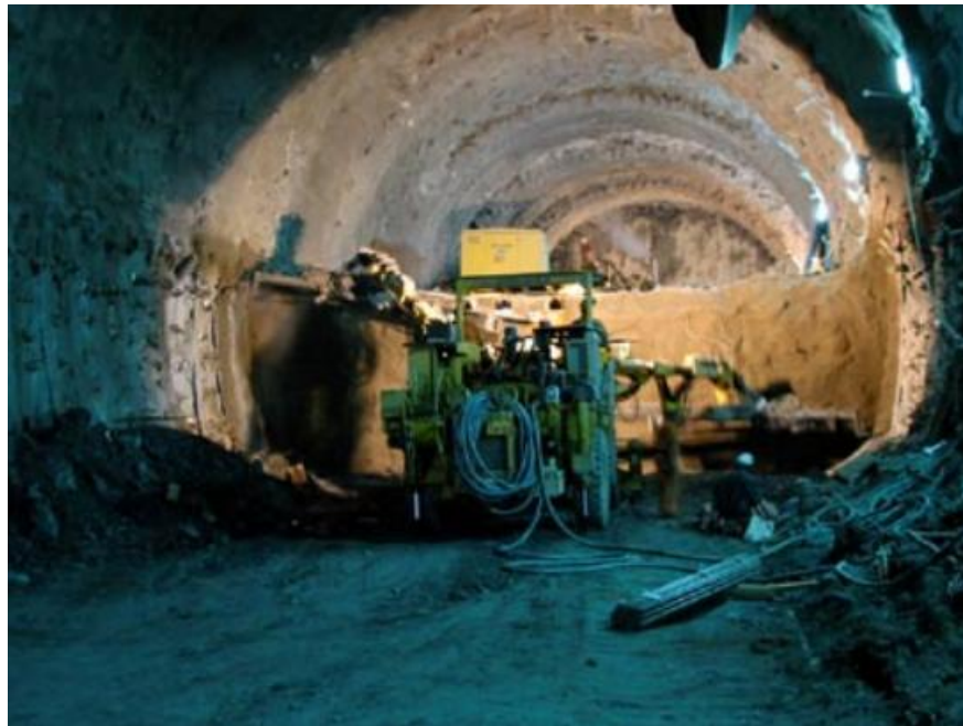
Εικόνα 3.6. Εργασίες κατασκευής της Β' Φάσης στη σήραγγα Ανθοχωρίου.
