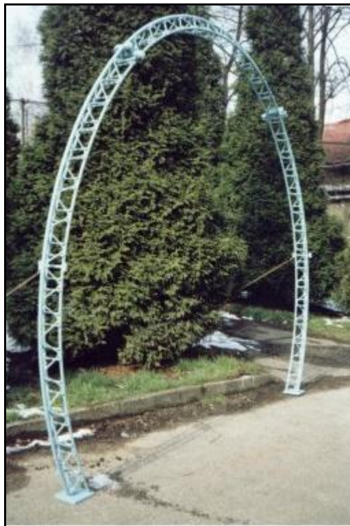
Εικόνα 4.3.Τυπική εικόνα δικτυωτού πλαισίου(lattice girder) κατασκευασμένο για την άμεση υποστήριξη σήραγγας πεταλοειδούς διατομής.
