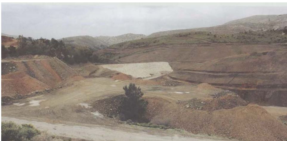
Εικόνα 6-7: Το φράγμα στο Σεραπίο
