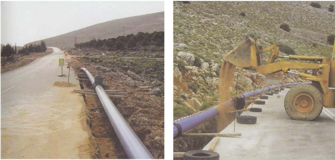
Εικόνα 6-12: Τεχνικά έργα δικτύου μεταφοράς νερού στην Λαγγάδα & στον Θόλο
