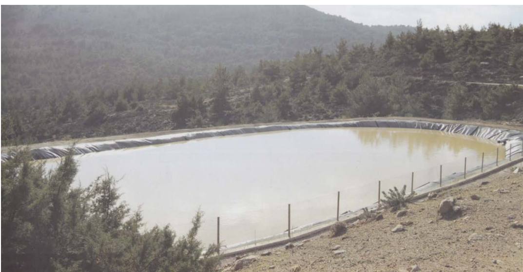
Εικόνα 6-9: Η λιμνοδεξαμενή στη θέση Αρβανίτισσα
