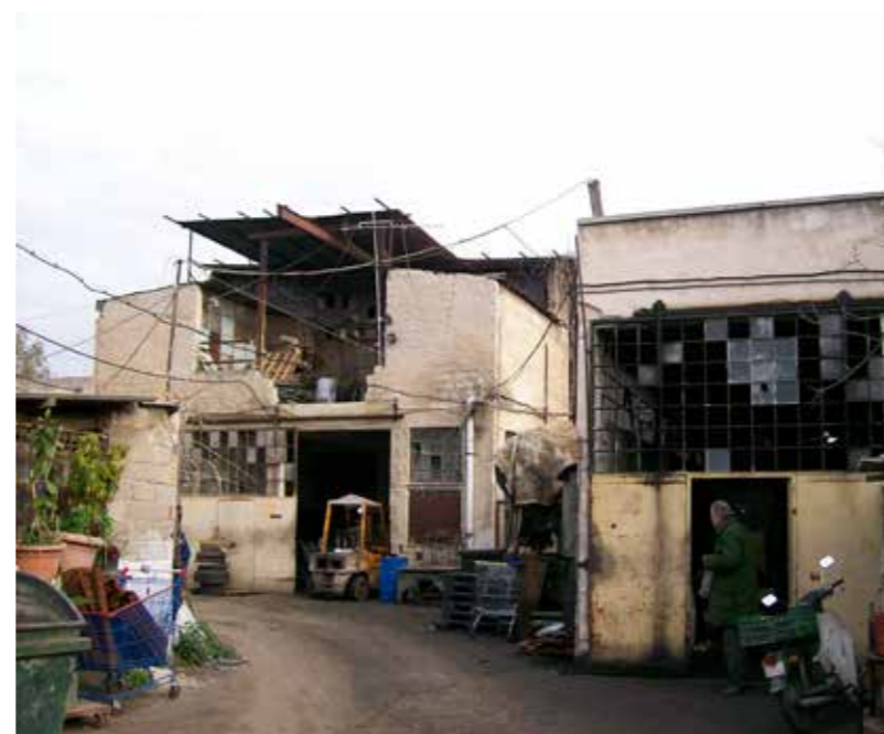
Εταιρεία παραγωγής ηλεκτρολογικού υλικού, προμηθευτής της ΔΕΗ, 2010.
