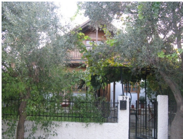
Εικ.6.1 Βόρεια όψη
