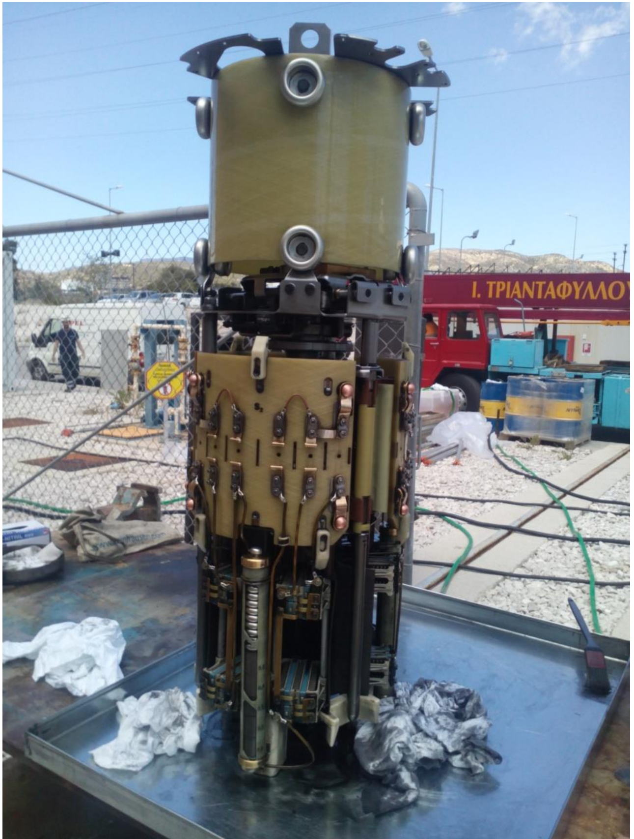
Εικόνα 2.12: Μεταγωγικός διακόπτης (diverter switch) τεχνολογίας ελαίου (oil) μετά το πέρας της συντήρησής του και πριν την επανεγκατάστασή του στο Μ/Σ ισχύος.
