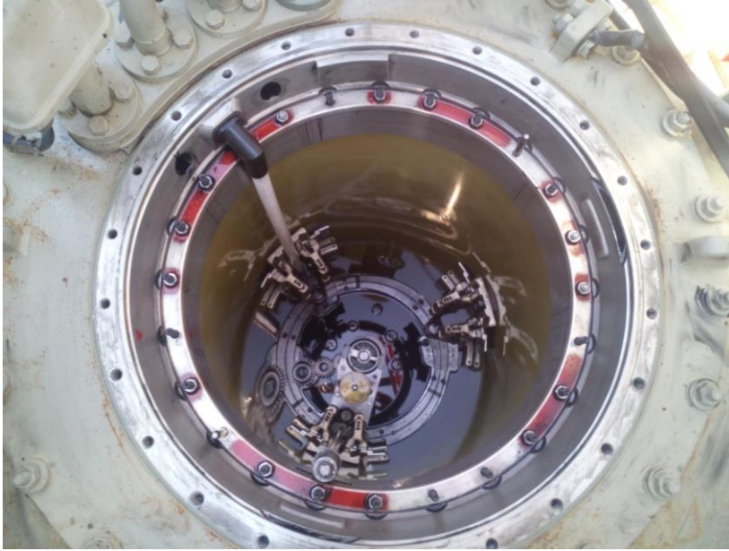
Εικόνα 2.17: Εσωτερικό διαμερίσματος ελαίου (oil compartment) κατά τη διάρκεια αφαίρεσης από αυτό του μεταγωγικού διακόπτη (diverter switch) για την πραγματοποίηση εργασιών συντήρησης.
