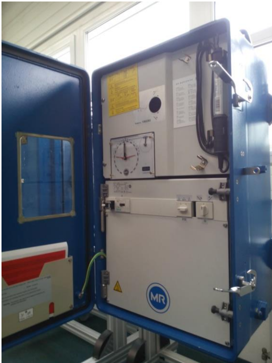
Εικόνα 2.18: Μονάδα οδήγησης (Motor Drive Unit, (MDU)) ενός ΣΑΤΥΦ.
