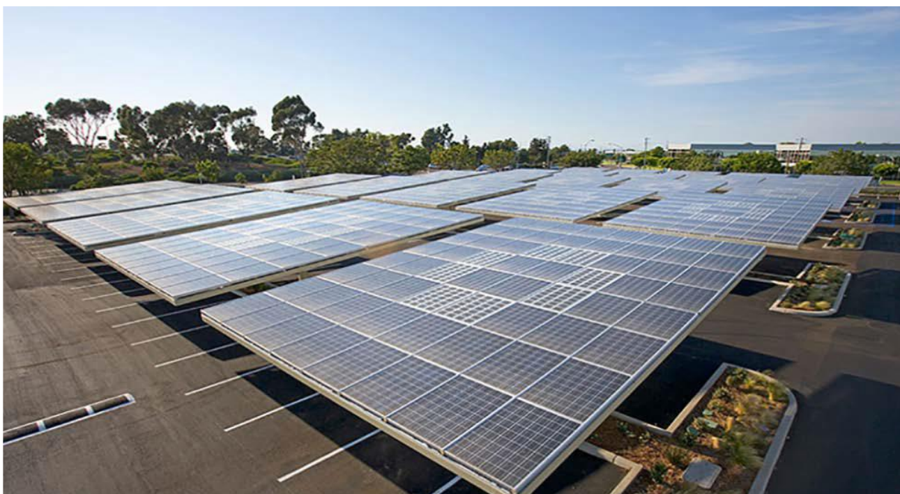
Εικόνα 7.5 Ειδικά διαμορφωμένα στέγαστρα αυτοκίνητων με φωτοβολταϊκά πάνελ πάνω τους [45]
