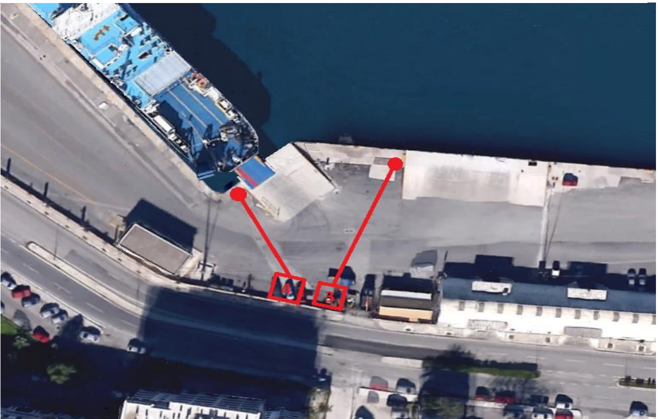
Εικόνα 5.7 Εγκατάσταση 3 ου και 4 ου σημείου ελλιμενισμού και υποσταθμού για οχηματαγωγά πλοία
