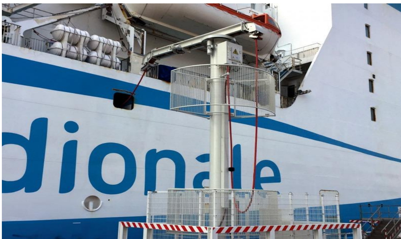
Εικόνα 3.10 Γερανός μεταφοράς καλωδίων [49]
