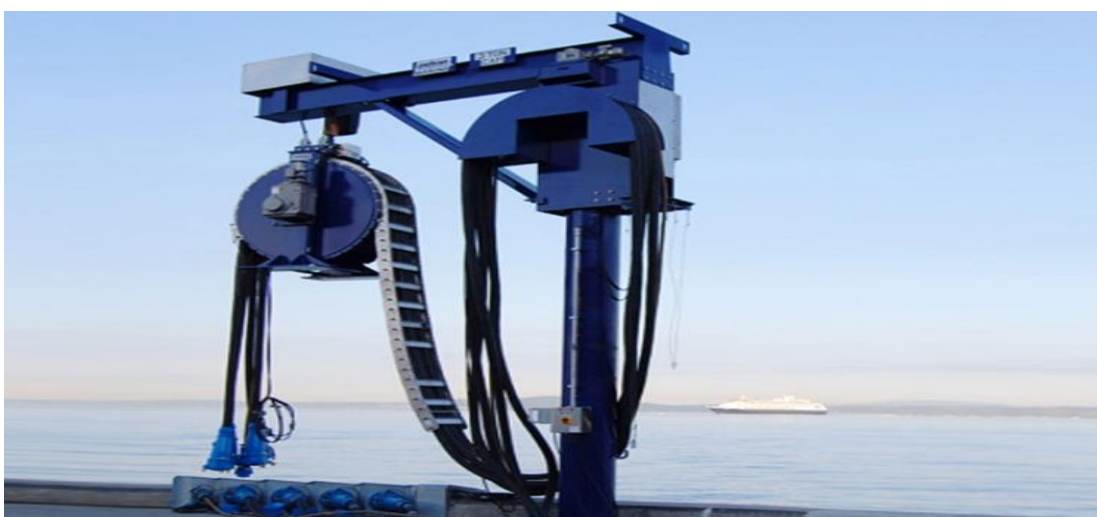
Εικόνα 22: Γερανός για τη μεταφορά καλωδίων ( www.marinelog.com/shipping/environment/cruise-ships-calling-halifax-can-now-plug-in-to-shoreside-power/ )
