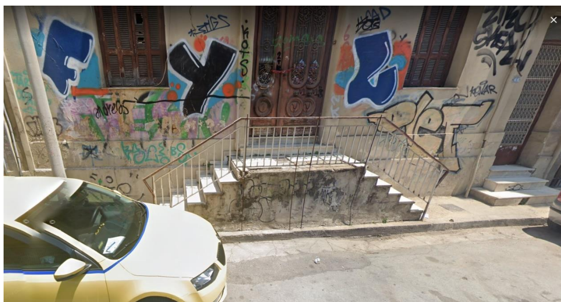
Σχήμα 71 - Σκάλα εμποδίζει τη διέλευση (E5=0), Πηγή: Google Street View, 2019.
