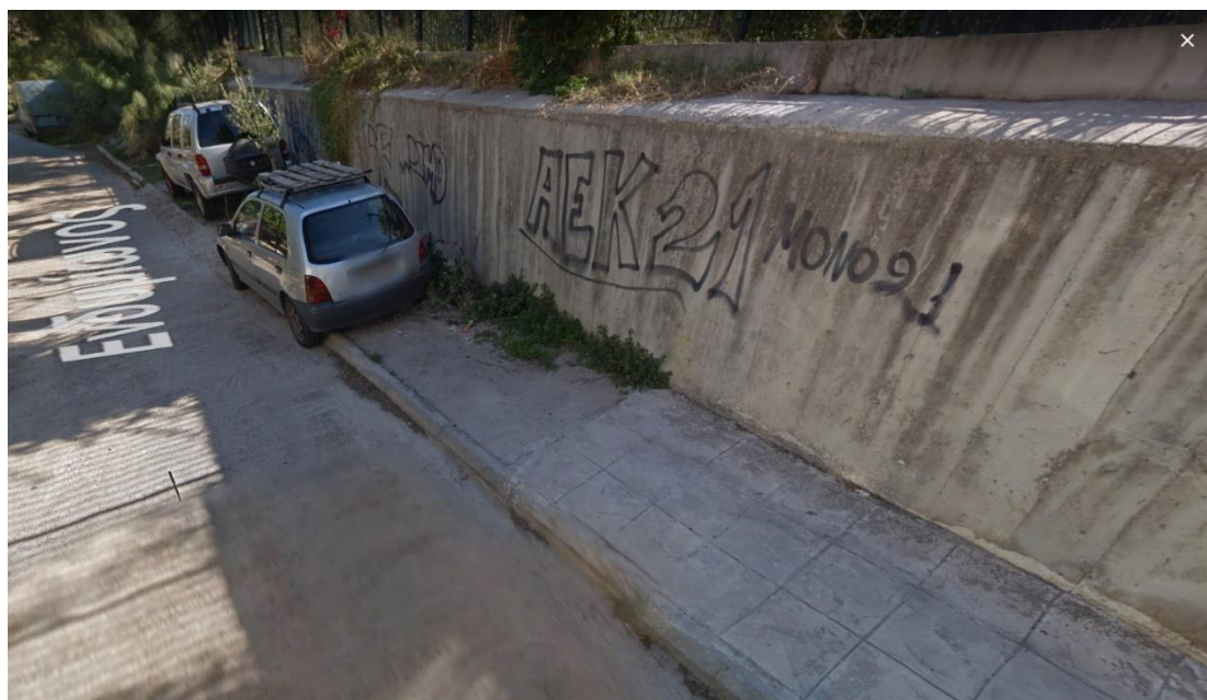
Σχήμα 70 - Ασυνεχές πεζοδρόμιο εμποδίζει τη διέλευση (E5=0), Πηγή: Google Street View, 2019.
