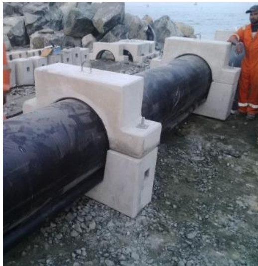
Σχήμα 5.6: Σταθεροποίηση του αγωγού με ειδικά διαμορφωμένους όγκους σκυροδέματος.
