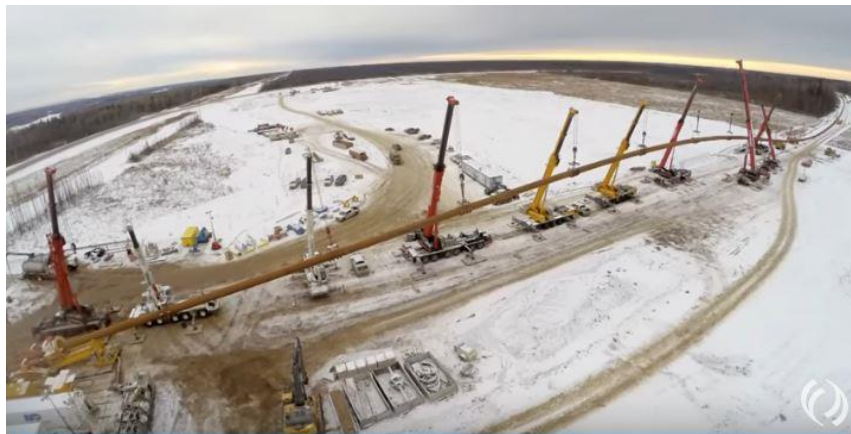
Σχήμα 3.14: Προώθηση του αγωγού στην ξηρά.
