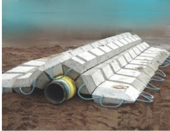
Σχήμα 5.5: Σταθεροποίηση του αγωγού με σάκους ενέματος.
