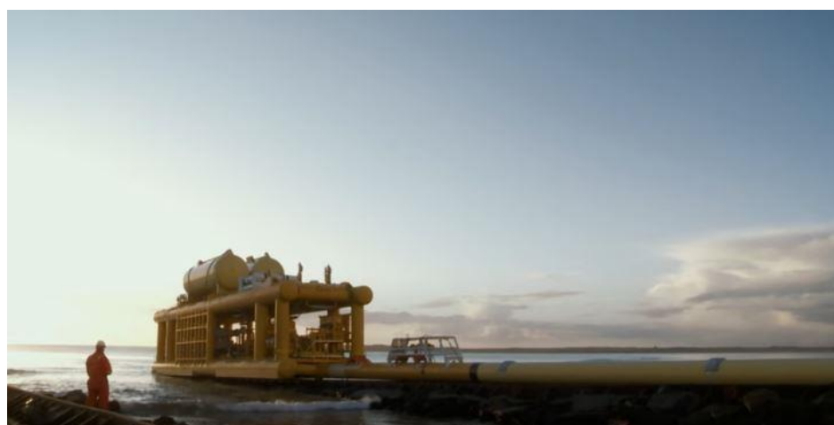
Σχήμα 3.15: Είσοδος του αγωγού στην θάλασσα.
