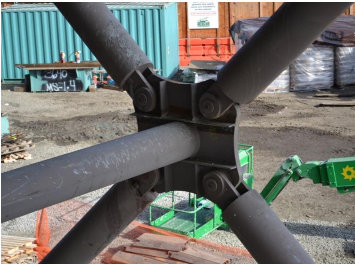
Σχήμα 1.6: Σύνδεσμοι δυσκαμψίας BRB στο Menlo Getaway[23]
