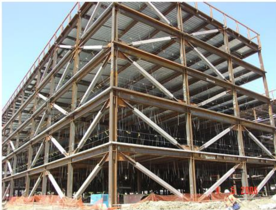
Σχήμα 1.3: Εφαρμογή στην πράξη των συνδέσμων δυσκαμψίας BRB [22]
