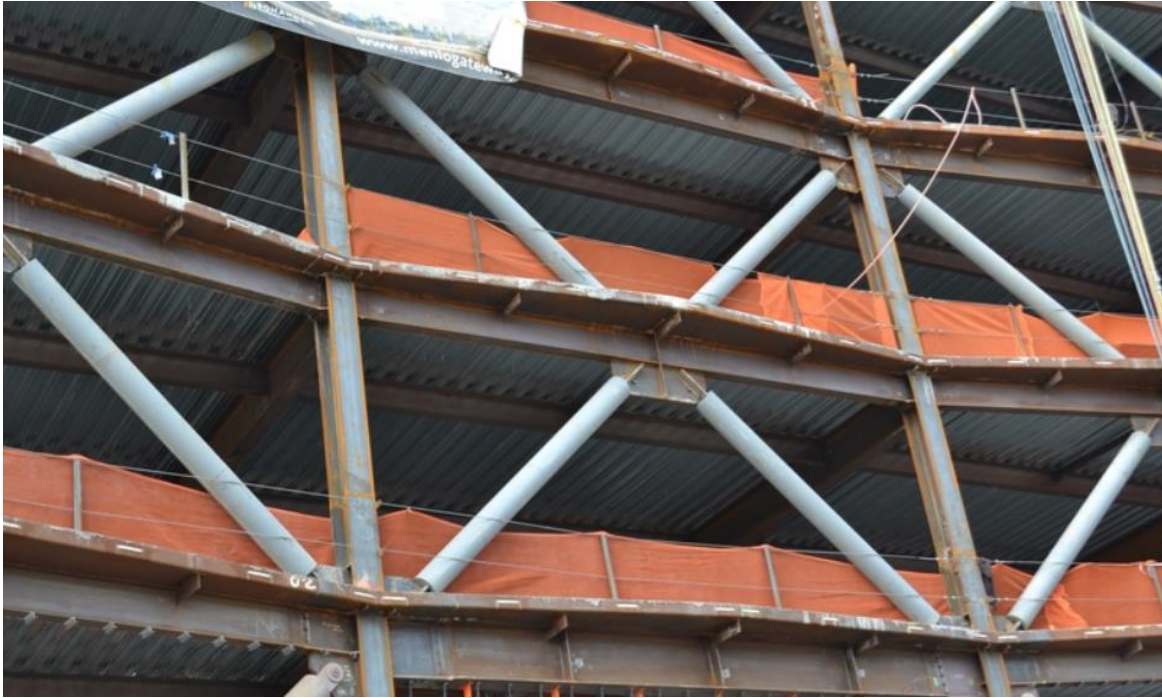
Σχήμα 1.5: Σύνδεσμοι δυσκαμψίας BRB στο Menlo Getaway[23]
