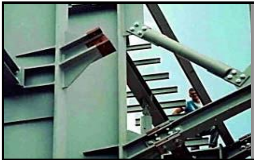
Σχ. 1.1. Σύνδεση μεταξύ μελών με κοχλίες
