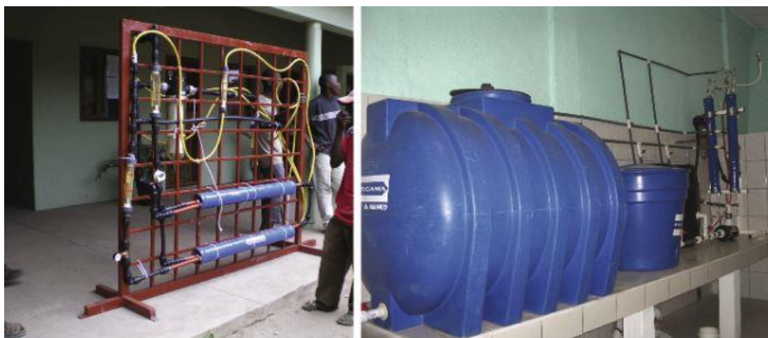
Σχήμα 4.6 Εγκατάσταση συστήματος υπερδιήθησης στο Δημοτικό Σχολείο Ressano Garcia (Μοζαμβίκη) και στο Σχολείο Mensajeros de la Paz στη Santa Isabel (Εκουαδόρ)
