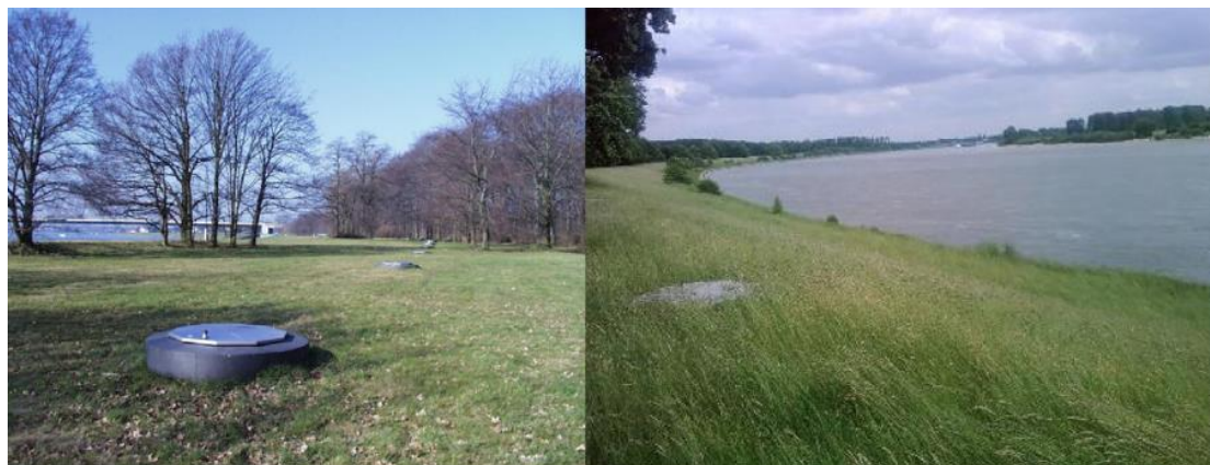
Σχήμα 4.15 Κατακόρυφα φρεάτια στο εργοστάσιο ύδρευσης Flehe. Ένα πηγάδι παρακολούθησης, το οποίο χρησιμοποιείται για την ανίχνευση χημικών ουσιών και παθογόνων μικροοργανισμών στο νερό του ποταμού σε περίπτωση διαρροής ή πλημμύρας, βρίσκεται μεταξύ του ποταμού και των κάθετων φρεατίων.
