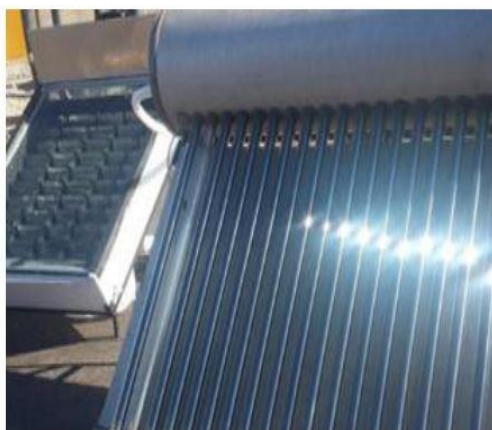
Σχήμα 3.17 Εφαρμογές συστημάτων ηλιακών αποστακτηρών μονής κλίσης ενσωματωμένοι με (αριστερά) ηλιακό συλλέκτη εκκενωμένου σωλήνα και (δεξιά) συλλέκτη επίπεδης πλάκας
