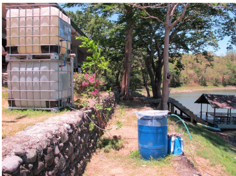
Σχήμα 4.2 Φίλτρο αργής διήθησης στο Fort Magsaysay στις Φιλιππίνες.
