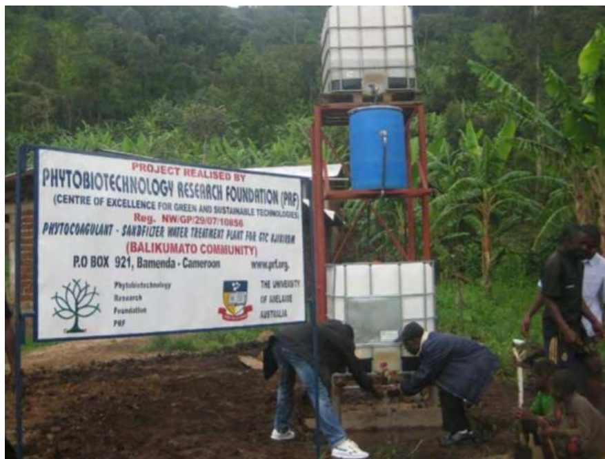
Σχήμα 5.4 πιλοτική μονάδα επεξεργασίας νερού με χρήση σπόρων Moringa oleifera και φίλτρου άμμου (Yongabi, 2012)
