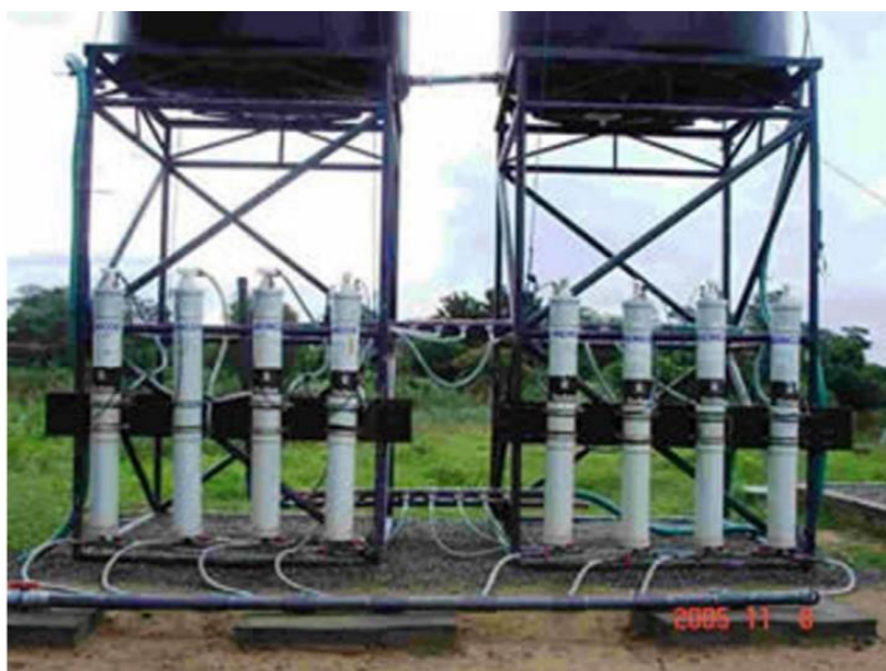
Σχήμα 4.10 Η εγκατάσταση του SkyHydrant απαιτεί μια αντλία ακατέργαστου νερού, μια δεξαμενή παροχής ακατέργαστου νερού που τροφοδοτεί το SkyHydrant και μια δεξαμενή αποθήκευσης πόσιμου νερού (Skyjuice Foundation, 2010).
